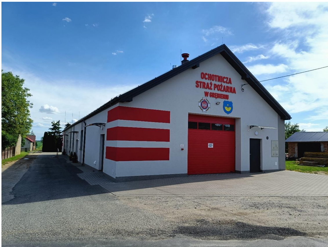
Fot. 5 Przebudowa budynku OSP Grębień
