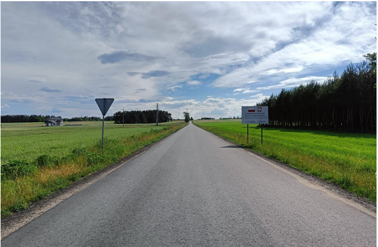
Fot. 6 Remont drogi powiatowej w Kalużach/Przebudowa drogi w Dziętrznikach
