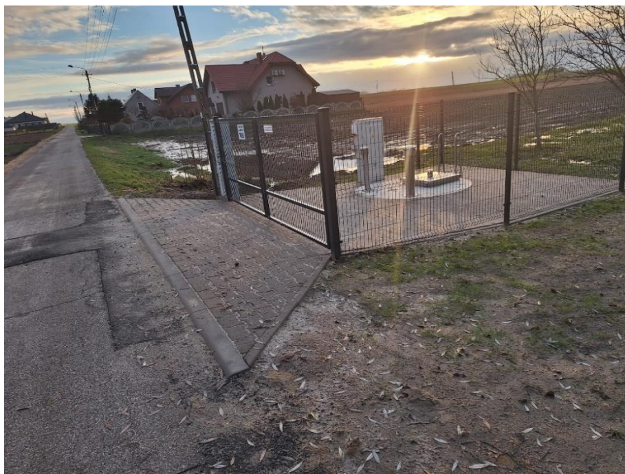
Fot. 3 Budowa kanalizacji sanitarnej w Popowicach
