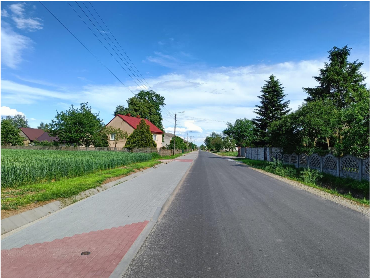
Fot. 9 Budowa drogi gminnej w Dzietrzniakach
