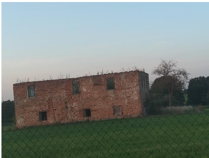
Rysunek 13. Dwór obronny w Kamionce – widok od strony północnej.
