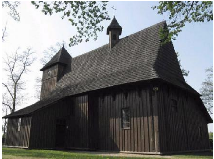
Rysunek 5. Widok na Kościół filialny pw. Św. Trójcy w Grębieniu.
